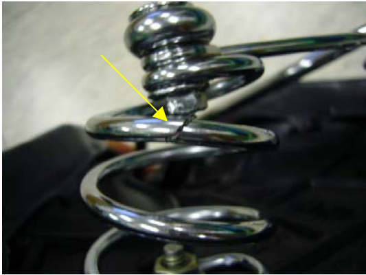
写真3 コイルばねの破損
